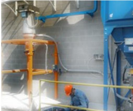
In uno stabilimento di produzione alimentare è stato installato un impianto di recupero dell'amido. Aspirati all'interno di un filtro, gli amidi si presentano come polveri fini, che dovevano essere immesse in un big bag da stoccare in un'area apposita.
