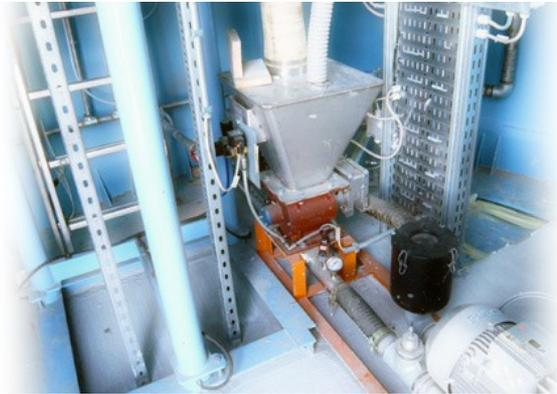
Un impianto di iniezione di calce idrata è stato installato in una vetreria. Si tratta di un sistema [J-PACK](#) modello RV di trasporto pneumatico ad aria in fase diluita.
